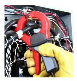
**Photo 2**: Install CT Around Conductor.
