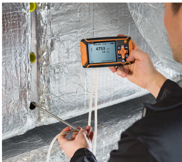
Appareil amovible permettant des mesures dans les canalisations au
